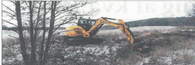
- Det bliver stadig sværere at få drænrørene ned i korrekt dybde, oplyser Lars Lohse. Nogle steder er den kommunale oprensning så mangelfuld, at rørene må lægges for øverligt i forhold til den optimale dybde på 110-130 centimeter. (Arkivfoto)
